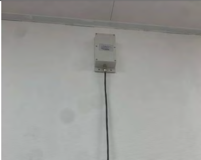
固定式剂量率监控探头（安装在迷道内）
